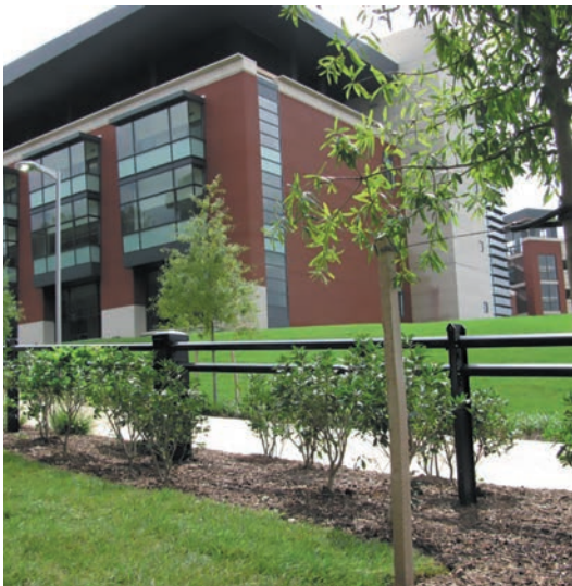
De kabel is geïntegreerd in de versterkingsrail. Er kunnen ook andere draden worden geïntegreerd.
