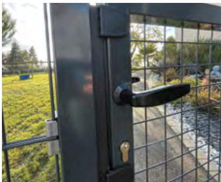
Ingebouwd slot met Europese cilinder
